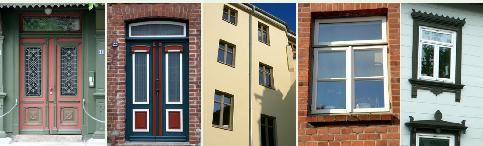
Abbildungen: Beispiele für vorbildlich sanierte Türen und Fenster
