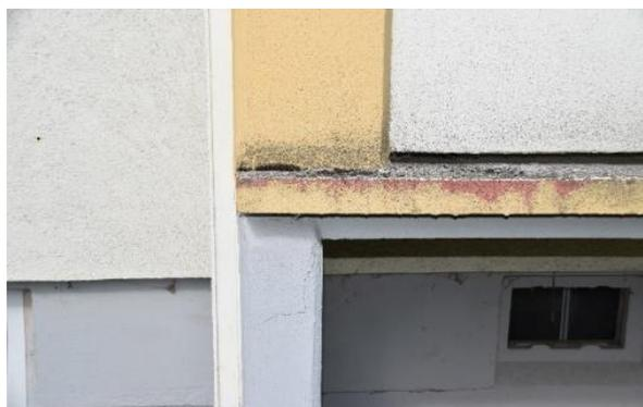
Abbildung 71: Detailaufnahme vorgehängte Balkone
